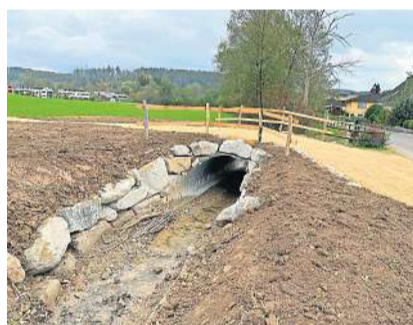
Der neue Durchlass ersetzt sanierungsbedürftige Brücke und behebt ein Hochwasserschutz-Defizit. zvg
